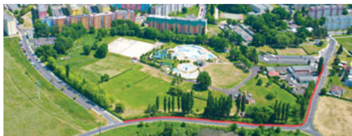
Stávající stav – v těchto místech bude vybudován chodník
