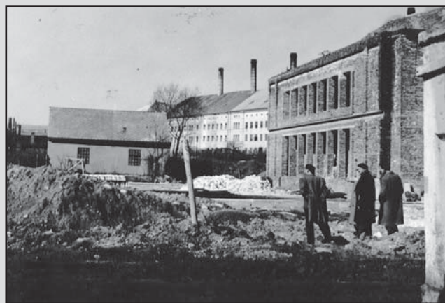
▼ Rok cca 1960, vlevo bývalá hasičská zbrojnice ...
