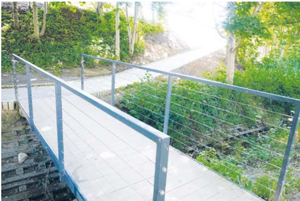
Na lávku přes Klášterecký potok nově navazuje chodník ke stadionu
