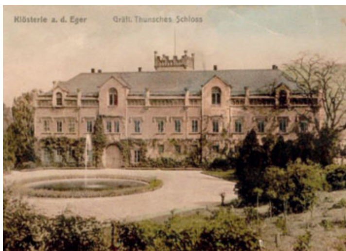
Zámek s původním vstupem na levé straně
