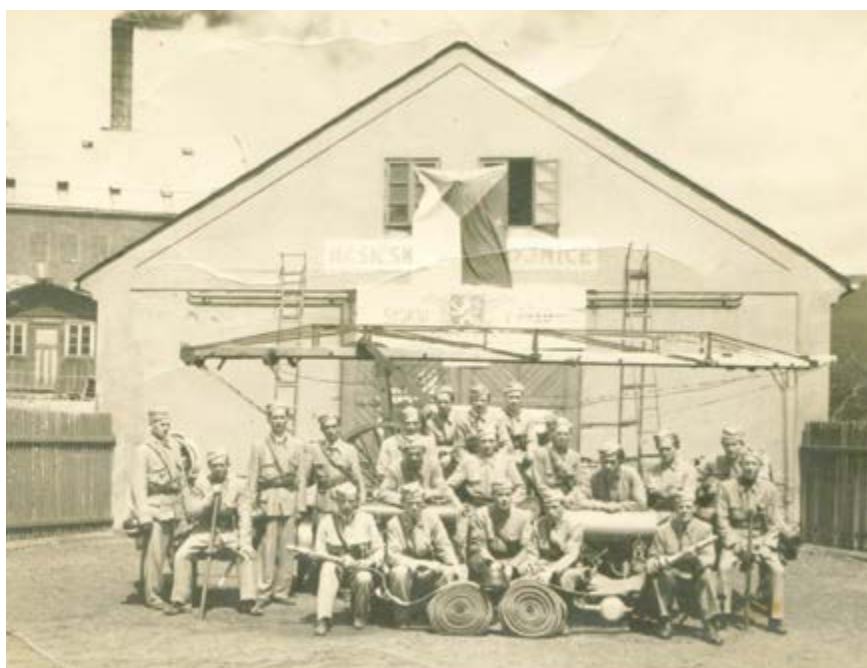
Hasičská zbrojnice v r. 1945 – nacházela se v místě dnešního kulturního centra
